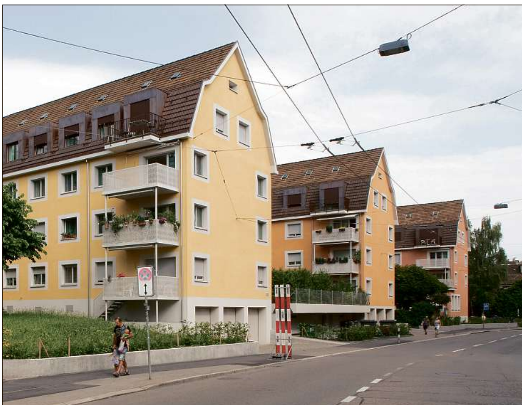
Ses project da parada – la sanaziun dals 13 blocs a Wiedikon.
